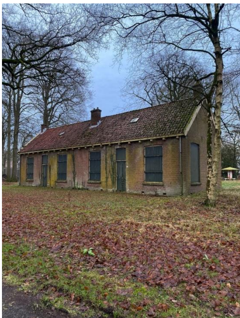
Figuur 27. Leegstaand en verpauperd pand naast Norgerhaven
